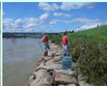
日常巡視状況
