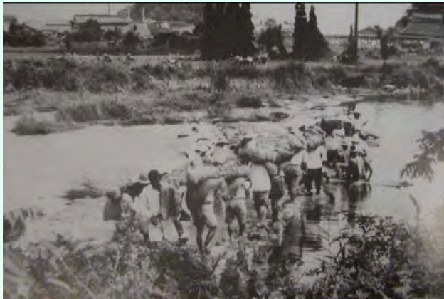
堰設置の様子(昭和32年:片吹井堰)
