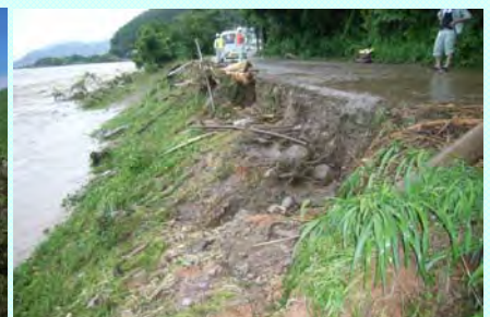
出水後の緊急点検
