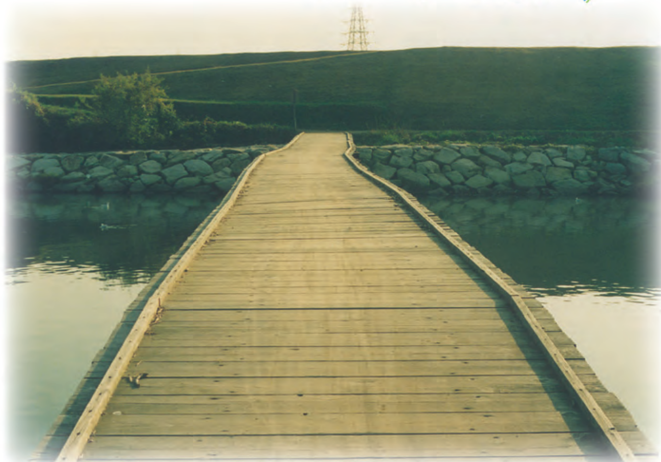
網干区 下余部 (八十大橋の前身の木橋・平成元年撮影)
