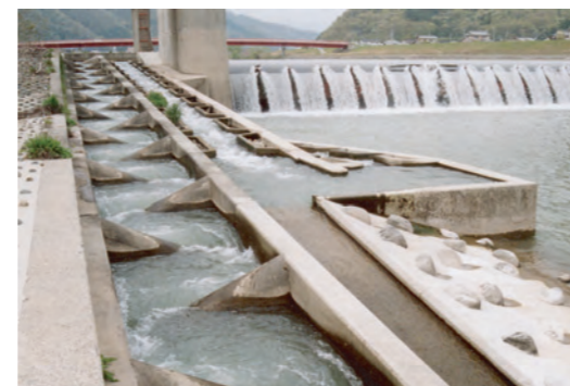
吉島統合頭首工の魚道
