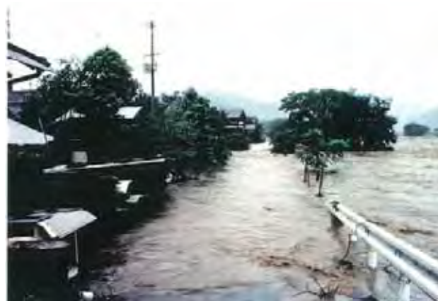
宍粟橋右岸浸水状況 (宍粟市山崎町)
