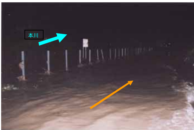
宍粟橋上流無堤地区(宍粟市山崎町)
