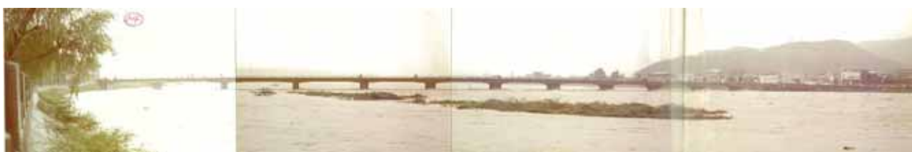
洪水中の龍野橋の状況(たつの市)
