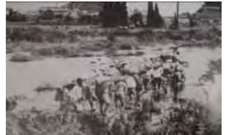
図-1.3.1 井堰設置の様子 (昭和32年:片吹井堰)
