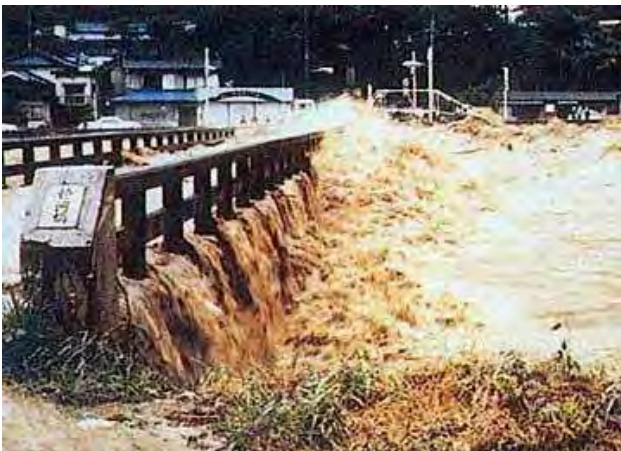
流失前の神河橋 かみかわ (宍粟市山崎町)
