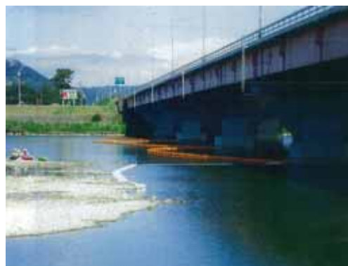
図-3.5.1 水質事故対応(オイルフェンス)
