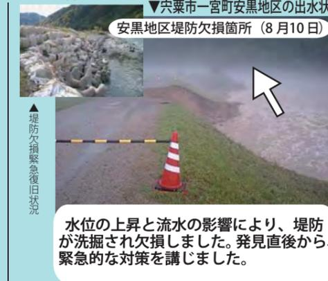
水位の上昇と流水の影響により、堤防が洗掘され欠損しました。発見直後から、緊急的な対策を講じました。
