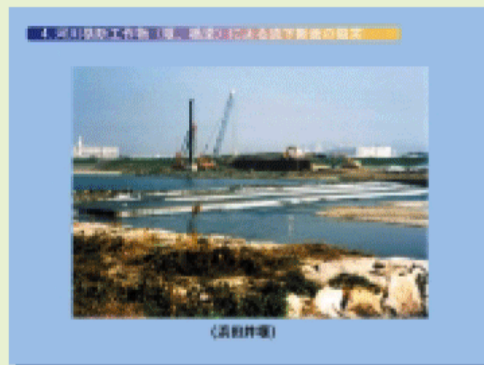
揖保川には多くの堰や橋梁があります(写真は浜田井堰の例)。これらの中には構造上の問題から流下能力を妨げているものがあります。
