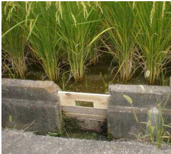
せき板設置状況(太子町)
