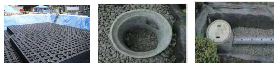
<雨水貯留浸透施設(左から貯留施設、浸透ます、浸透トレンチ)>
