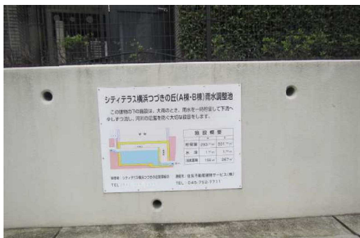
地下貯留施設を示す看板の例
