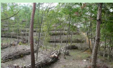
過密林の伐採後に土留工を設置
