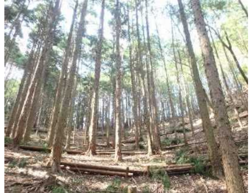
伐倒木の土留工
