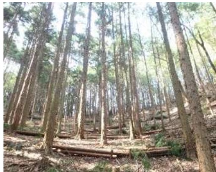
伐倒木の土留工
