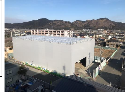
防音ハウス施工状況
