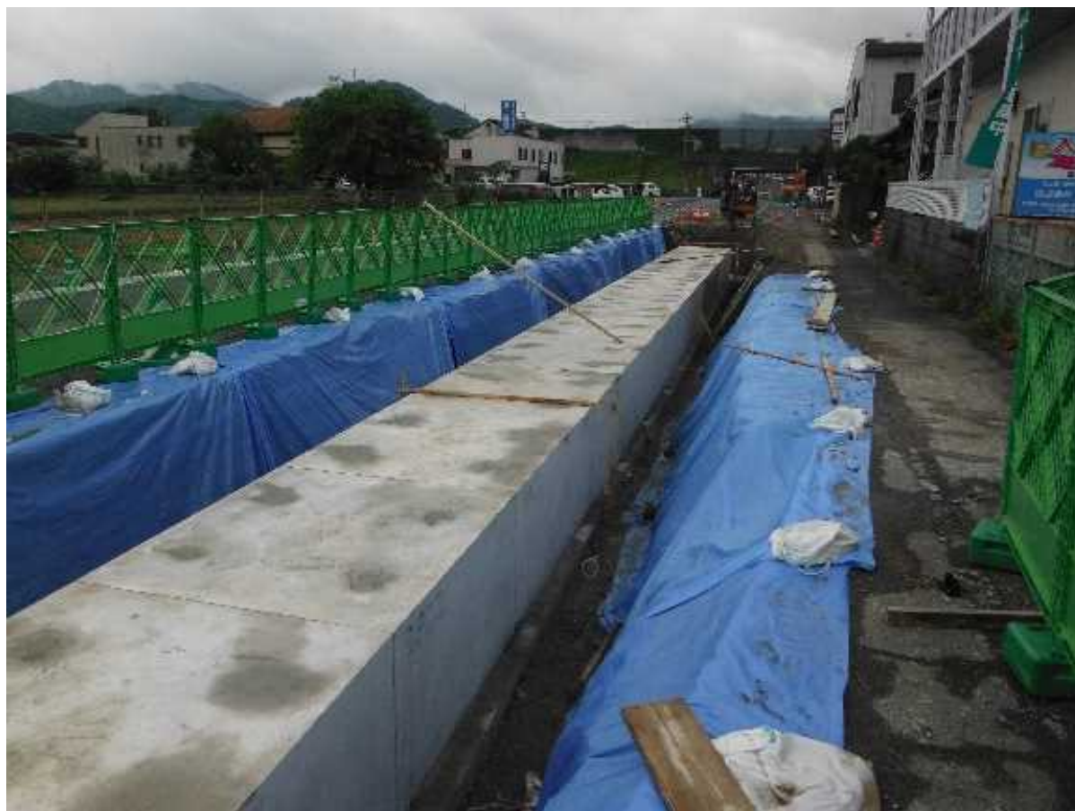
工事中の幹線排水路
