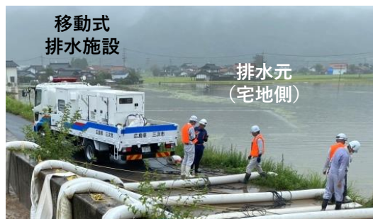
樋管のゲートにポンプを設置
