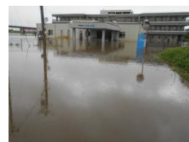
浸水時の状況 (喜多方市提供)
