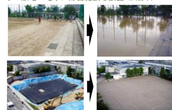
上：校庭周囲に設置した小堤による貯留（兵庫県） 下：敷地の地下に貯留施設を設置（西宮市）
