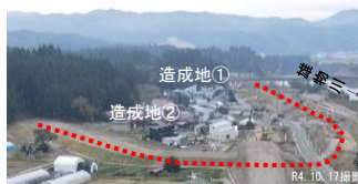
移転家屋の建設が進む状況
