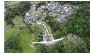
砂防堰堤の設置 (兵庫県 龍野土木事務所)
