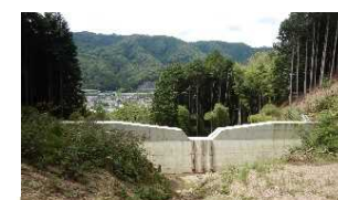
治山ダムの設置 (兵庫県 光都農林振興事務所)
