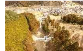
砂防堰堤の設置 (兵庫県 姫路土木事務所)
