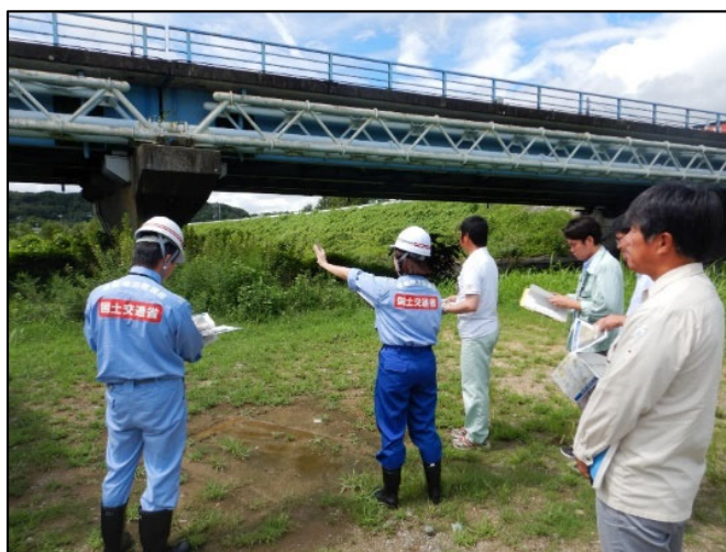
揖保川右岸11.8k付近 【たつの市との共同点検状況】 龍野新大橋
