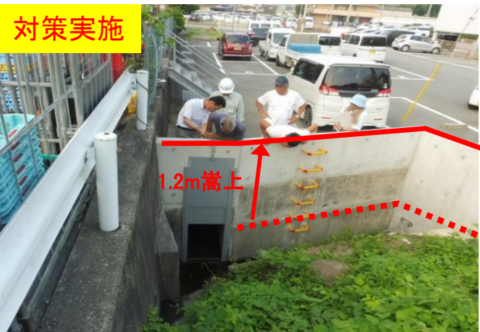
逆流により浸水した箇所の雨水柵の壁高を1.2m嵩上げ
