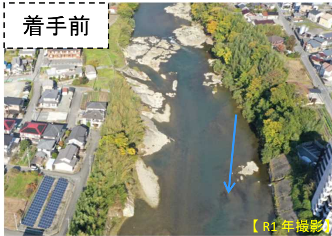
【④上滝野地区河道掘削の実施状況】（国施行）
