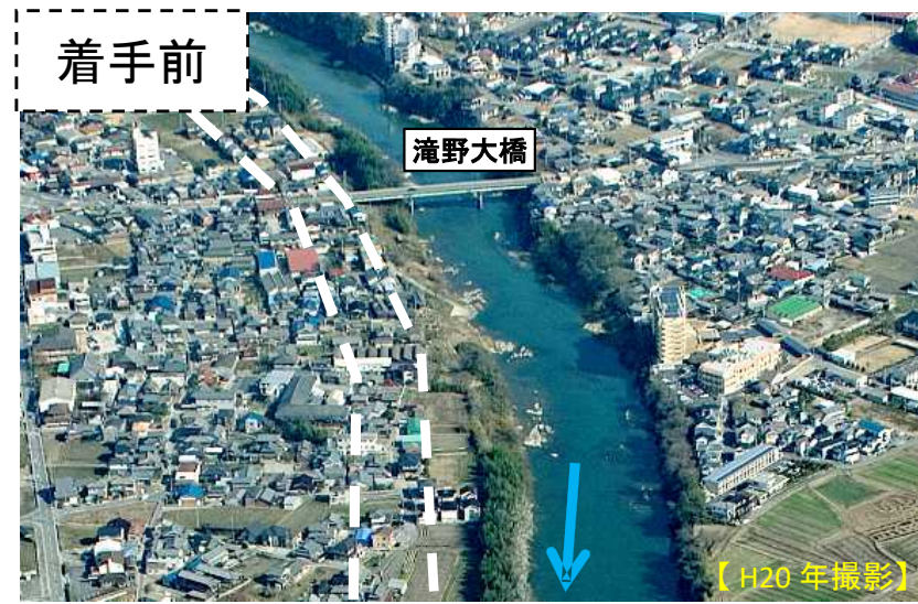
【③下滝野地区の築堤実施状況】 (国施行)
