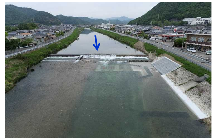
和田井堰(R3.5状況)
