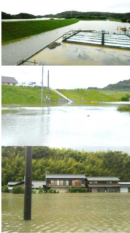
【過去の被災状況】
