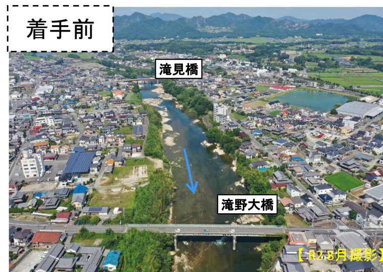
【③上滝野地区の築堤実施状況】 (国施行)
