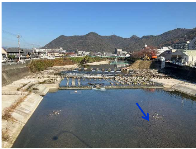
沖田井堰 (R4.11状況)
