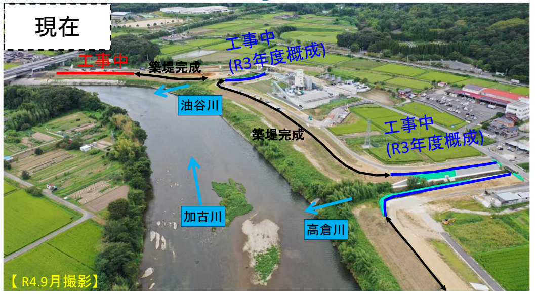
バック堤施工状況
