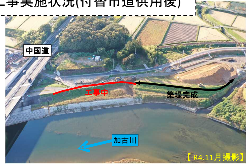
バック堤施工状況
