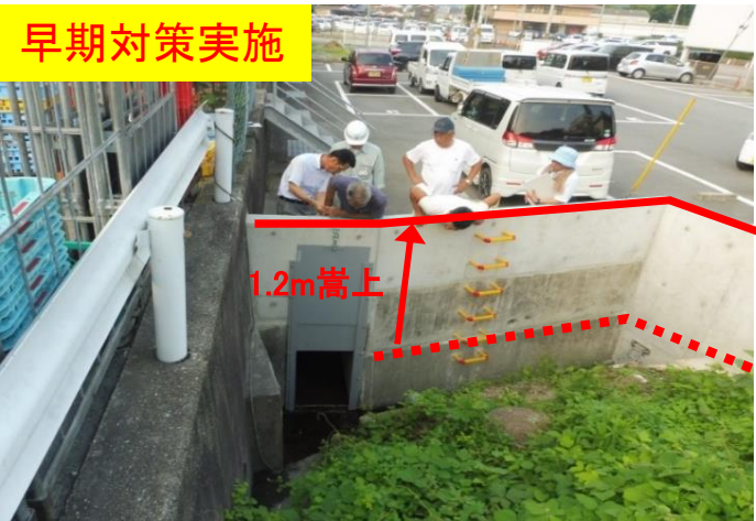
[30年7月豪雨時] 加古川の水位上昇により水路が逆流し、浸水被害が発生
