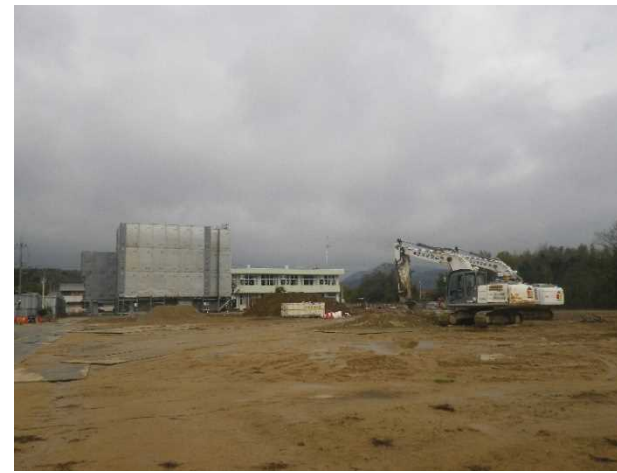
旧東条東小学校工事の様子
