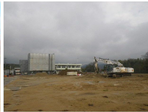
旧東条東小学校工事の様子
