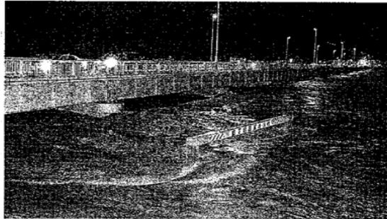
21年ぶりに危険水位を突破、橋のすぐ下まで水位が上昇した加古川。20日午後2時半、加古川市加古川町の加古川川原付近
