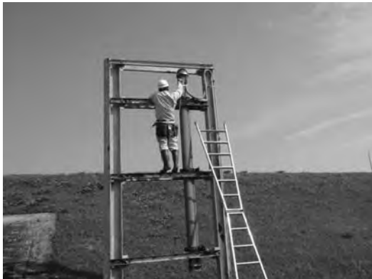
水位観測所点検の様子
