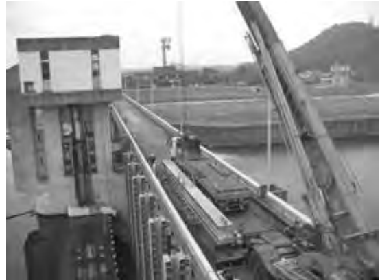
加古川大堰修繕工事の様子
