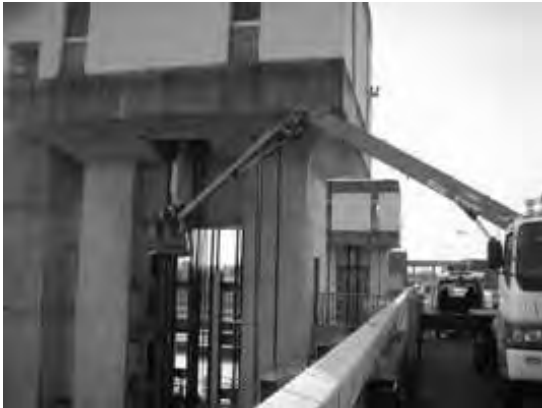
加古川大堰点検の様子
