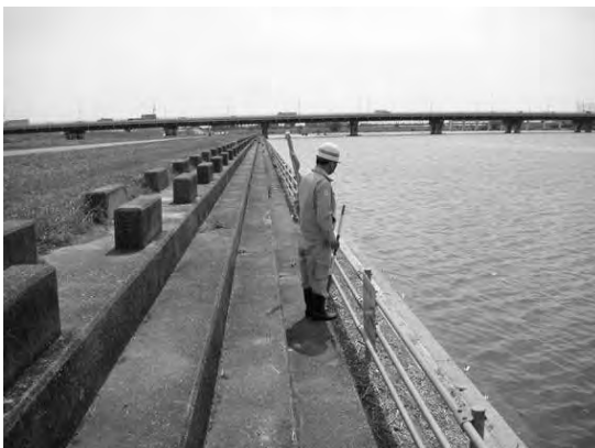
河川利用者の安全確保点検の様子
