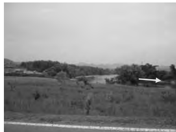
堤防が無い区間 (加東市)
