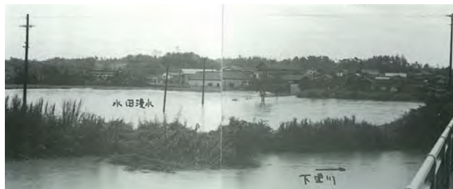
加西市の浸水状況
