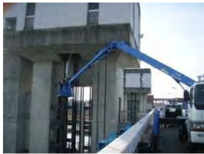
加古川大堰点検
