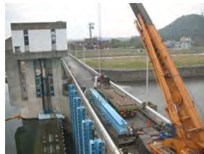
加古川大堰修繕工事
