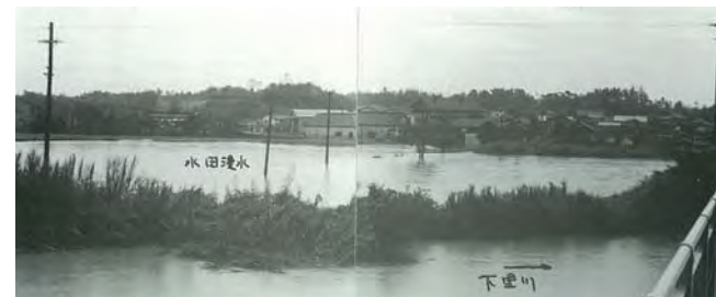
加西市の浸水状況（昭和51年）
