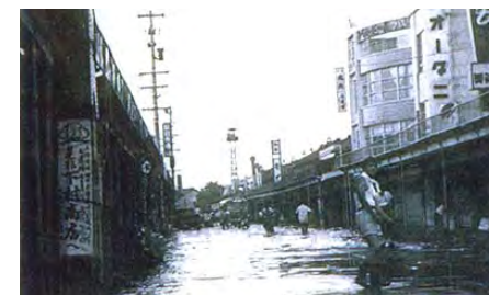
西脇市内の浸水状況（昭和40年）
