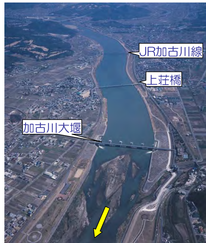
加古川大堰湛水区間
