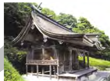
黒谷若宮八幡宮本殿 (室町 永禄7)
