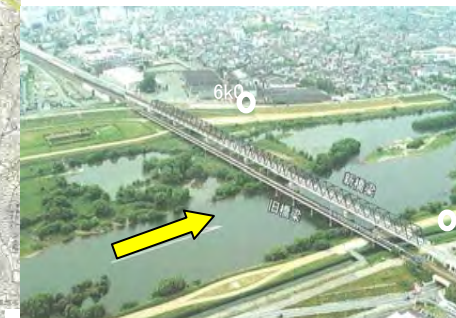
JR山陽本線加古川橋梁架替
