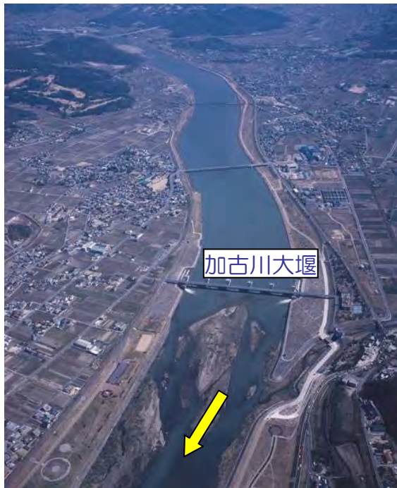
下流部（加古川大堰周辺）
