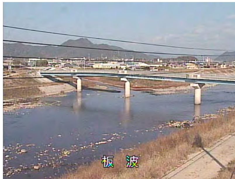
板波観測所のCCTVカメラ画像
