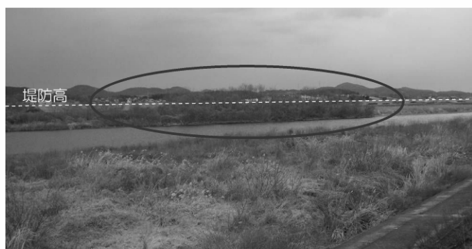
堤防高を越える高さの樹木 （加古川市河川公園）
