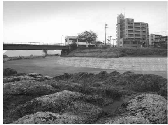
＜改修後の闘竜灘の状況＞
