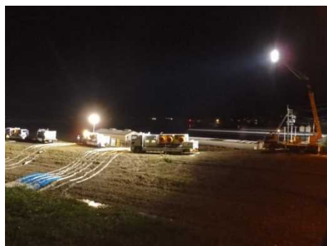
照明車による夜間作業支援
