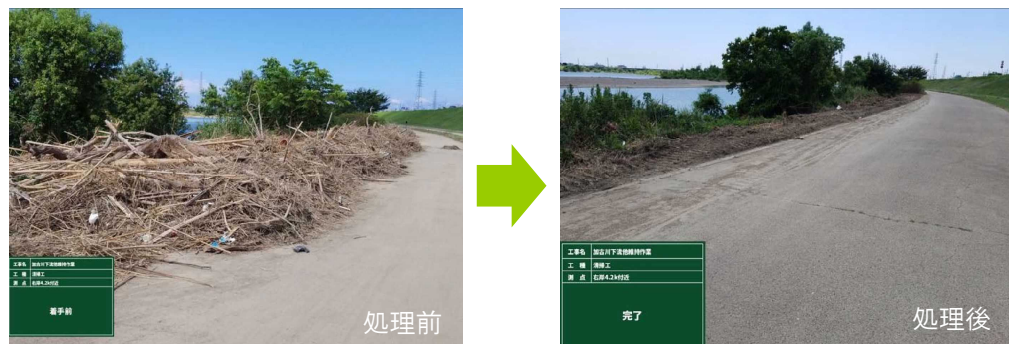
加古川右岸4.2k付近 塵芥処理状況
