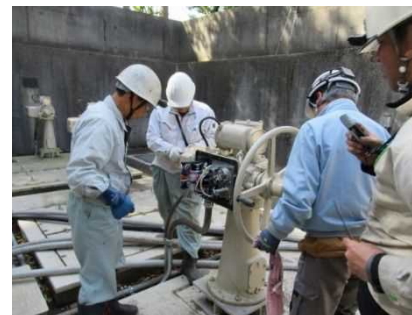
流量調整バルブ点検作業
