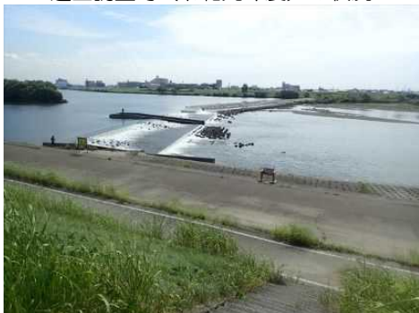
遡上調査時（令和元年度）の状況
