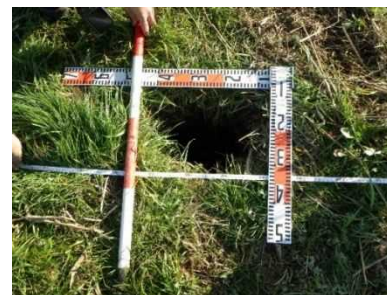
補修前（高水敷陥没）
