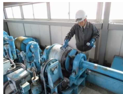
機械設備点検作業
