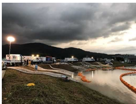
排水ポンプ車による排水作業
