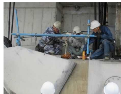
大堰上段扉シーブブロック調整作業
