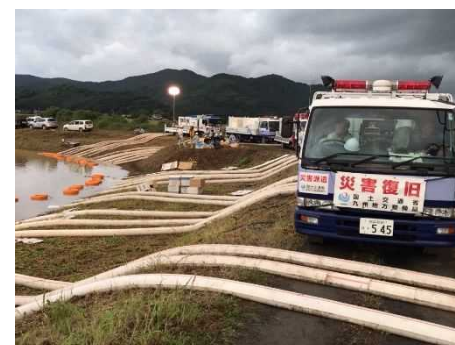
排水ポンプ車による排水作業
