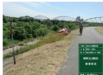
遠隔操縦式草刈り機による除草（左）および集草（右）状況
