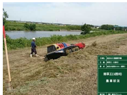
遠隔操縦式草刈り機による除草（左）および集草（右）状況
