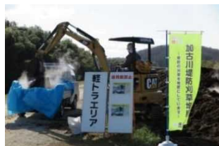
重機による積み込み
