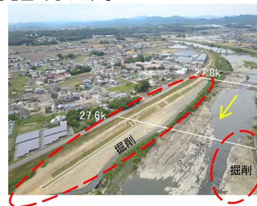
(河道掘削実施状況)
