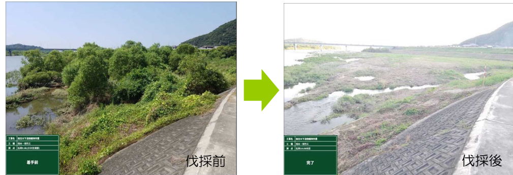
加古川右岸9.6k付近（小川合流部）河道内樹木伐採状況
