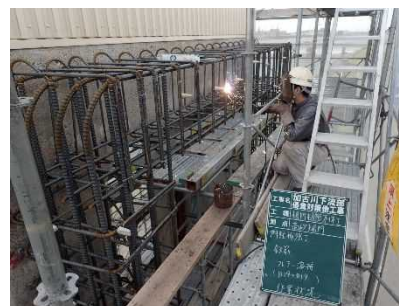
樋門の耐震対策 門柱補強（高砂樋門）
