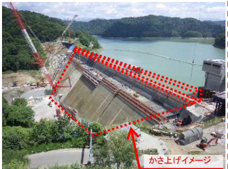
ダム建設・ダム再生
