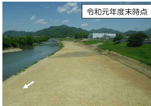
加古川河床掘削工事 (西脇市・県管理区間)
