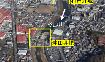
<堰改築事例(杉原川)>兵庫県
