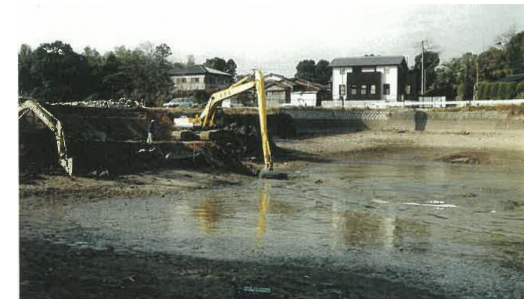
<ため池の浚渫工事>
