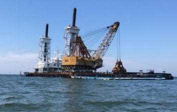
<河道掘削事例(加古川河口部)>姫路河川国道事務所
