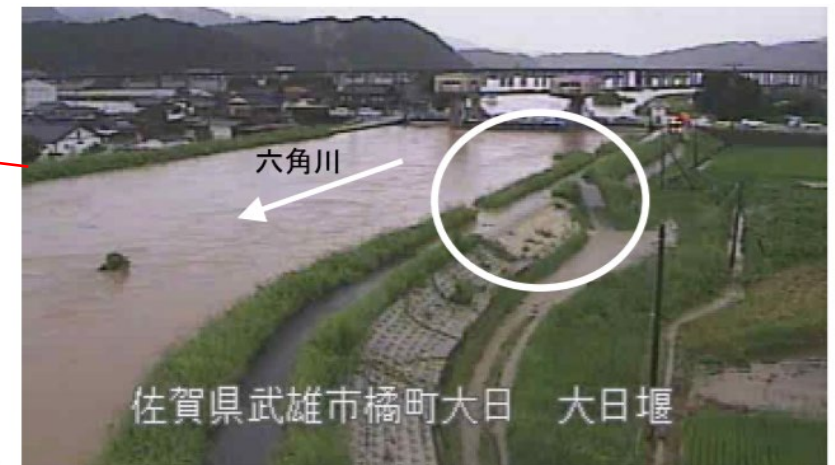
③ 8/14 6:40 六角川29k000付近 武雄市橋町大日付近(越水状況)
