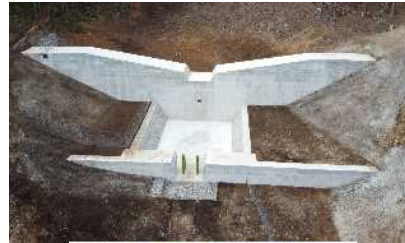
砂防堰堤の設置 (兵庫県 加東土木事務所)
