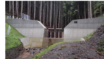
部分透過型治山ダムの設置 (兵庫県 加東森林農林振興事務所)
