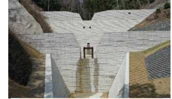
砂防堰堤の設置 (国土交通省 六甲砂防事務所)
