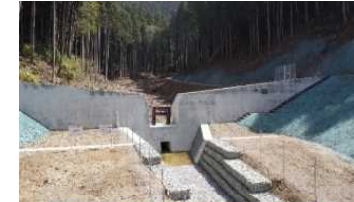
砂防堰堤の設置 (兵庫県 加東土木事務所)
