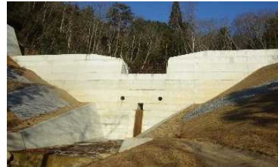
砂防堰堤の設置 (国土交通省 六甲砂防事務所)
