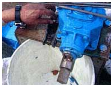
開閉装置潤滑油交換
