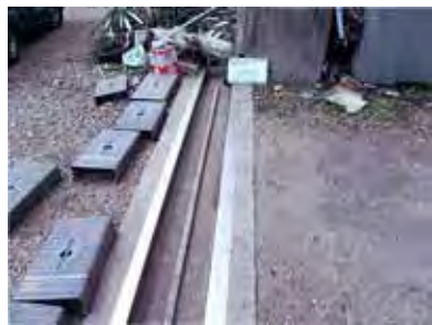
戸当り堆積土砂撤去
