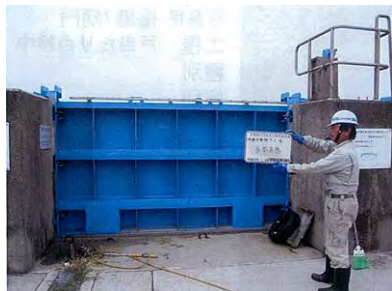
門扉動作確認
