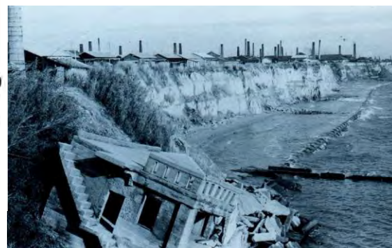
昭和39年 侵食で崩落したタコ壺工場(江井ヶ島地先)
