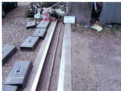
戸当り堆積土砂撤去
