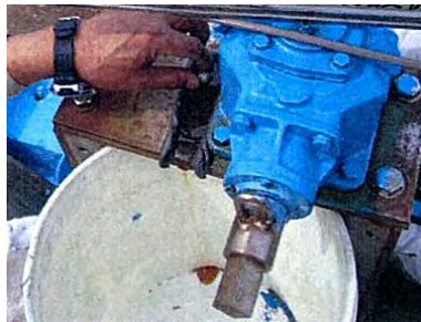
開閉装置潤滑油交換
