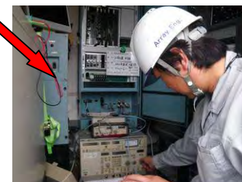
無線中継所点検
