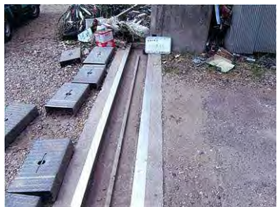
戸当り堆積土砂撤去
