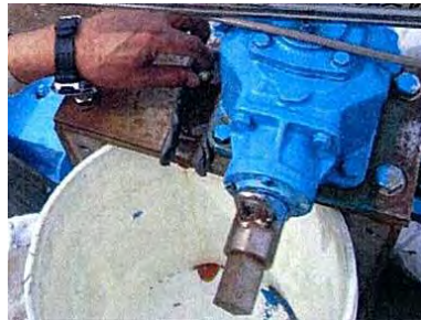
開閉装置潤滑油交換
