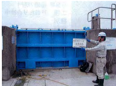
門扉動作確認
