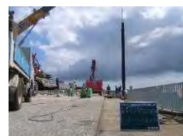
(目地施工状況)
