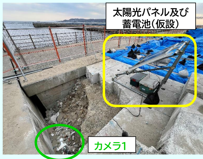
カメラ設置状況
