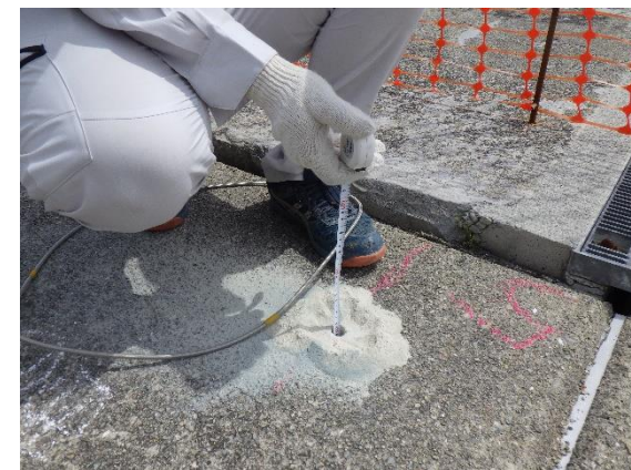
コンベックスによる空洞深さ計測
