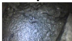
・カメラを空洞底面まで 挿入して撮影、空洞底面 においては石を確認。
