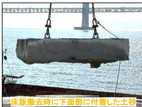
開削作業で生じた凹みの要因例
