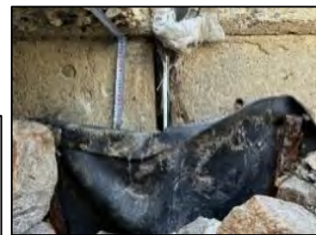
防砂板上端とケーソン上部工の隙間
