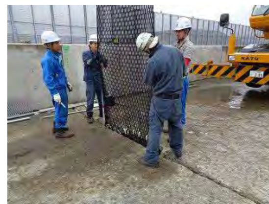
ケーソン目地透過波低減法の施工例
