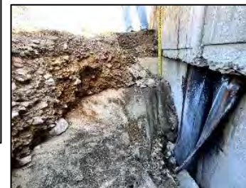
基礎碎石及び土砂層の流出状況
