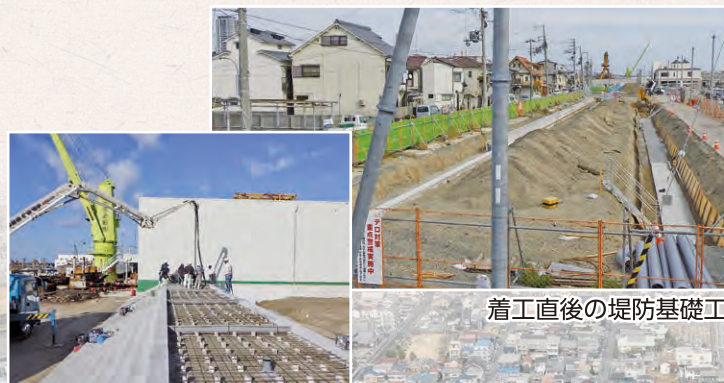
堤防天端へのコンクリート打設
