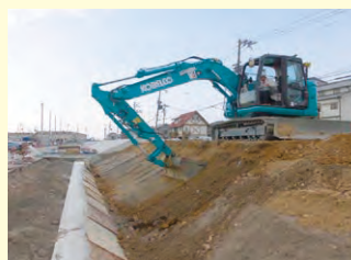
着工直後の堤防基礎工
