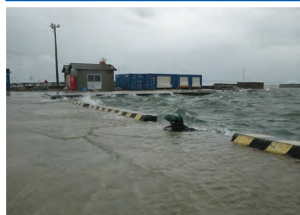
平成30年 台風21号による 高潮の様子
