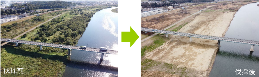
加古川左岸9.0～9.4k付近河道内樹木伐採状況
