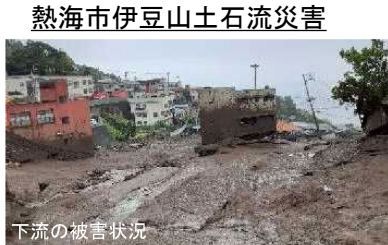
⑥土石流災害の状況 (静岡県熱海市)
