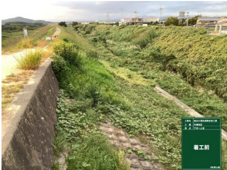
浸透対策（加古川 市場地区）
