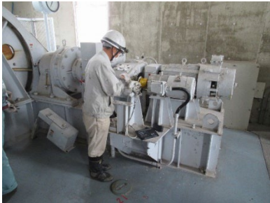
点検作業状況
