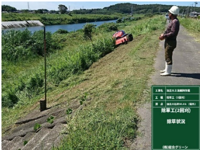
遠隔操縦式草刈り機による除草状況
