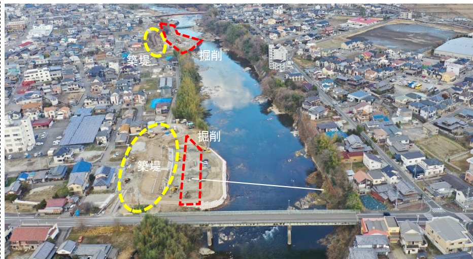
(河道掘削実施状況)
