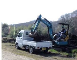
機械積み状況
