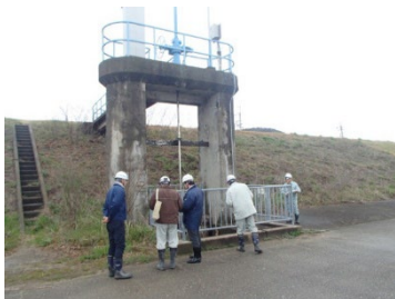
許可工作物の点検状況
