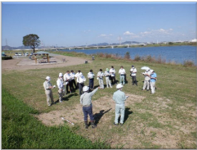
堤防点検の実施状況
