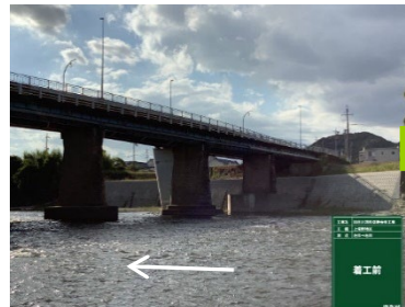
施工前(旧橋撤去前)
