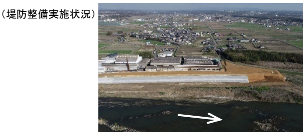
築堤・側帯盛土 (代表横断面 27.0k付近)
