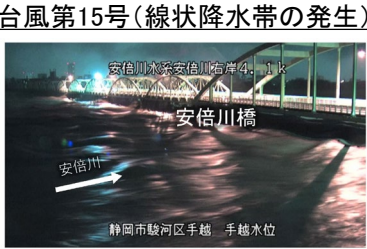
⑦安倍川の出水時の状況 (静岡県静岡市)
