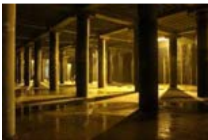
大規模地下貯留施設(下水道)
