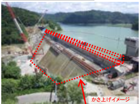
ダム建設・ダム再生
