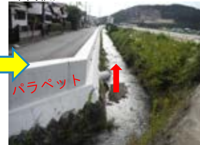
輪中堤による背水対策 （法華山谷川水系）
