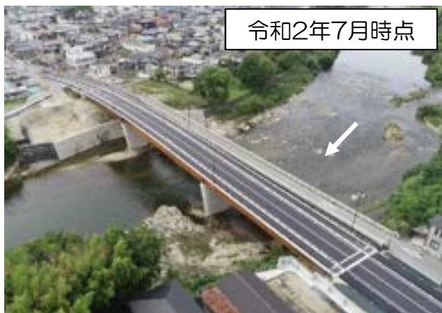
令和2年7月時点 加古川橋梁改築工事 （加東市・国直轄管理区間）
