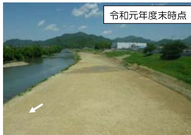
令和元年度末時点 加古川河床掘削工事 （西脇市・県管理区間）
