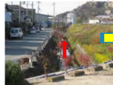
輪中堤による背水対策 （法華山谷川水系）
